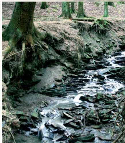
Ufererosion und Unterspülung der Fichtenwurzeln an der Broubich
