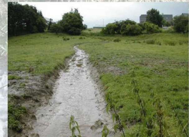
la végétation des berges est détruite : érosion et absence d'habitat (photo : CR Haute-Meuse)
